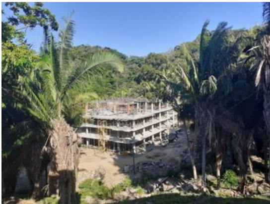
Blick auf die Großbaustelle der ZEDE Próspera, Quelle: Hondurasdelegation
