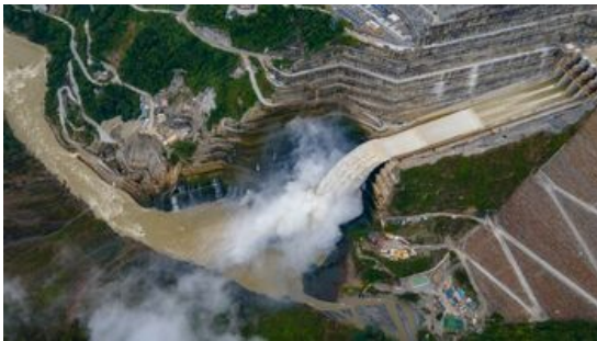
Luftaufnahme des Megadamms Hidroituango. Die Opfer dieses Megaprojekts kämpfen weiterhin für Gerechtigkeit und Wiedergutmachung. Quelle: Twitter: Secretario de Gobierno de Medellín
