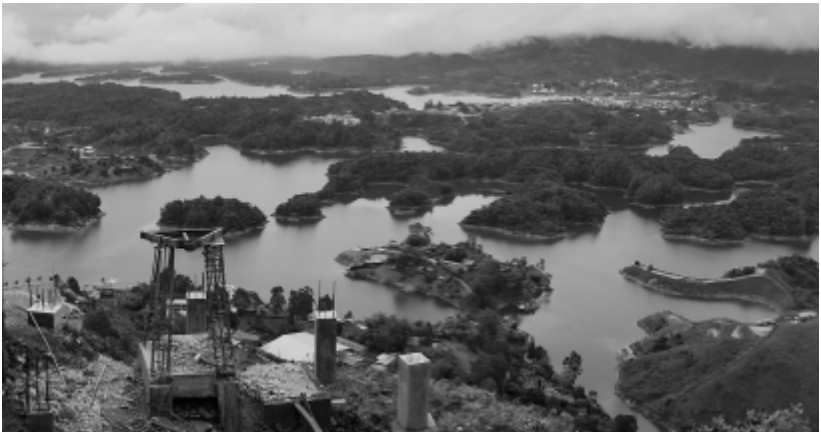
Das Foto wurde in der Mitte des Jahres an einem der größten Staudämme des Landes, El Peñol, aufgenommen. Der Stausee hatte bereits einen niedrigen Wasserstand. Die Situation Ende 2023 war kritisch
