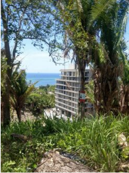
Baustelle der bis zu 14stöckigen "Duna Ressorts" der Privatstadt Próspera auf Roatán. Foto: HondurasDelegation
