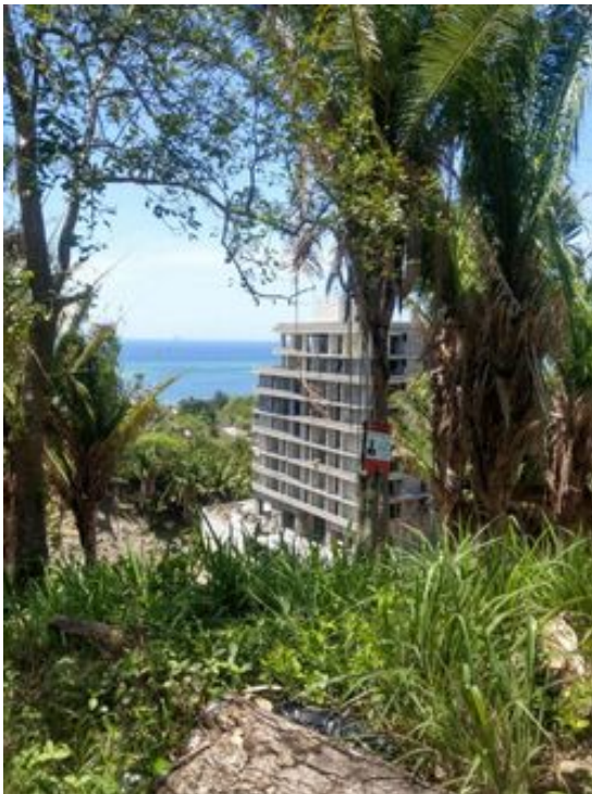
Obras de construcción del complejo de hasta 14 plantas "Duna Resorts" en la localidad privada de Próspera, en Roatán. Foto: HondurasDelegation
